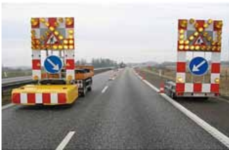
Figur 1. Med to tavlevogne dannes en "port", der videreføres forbi arbejdsområdet ved brug af to keglерækker, der afgrænser begge sider af køresporet.
