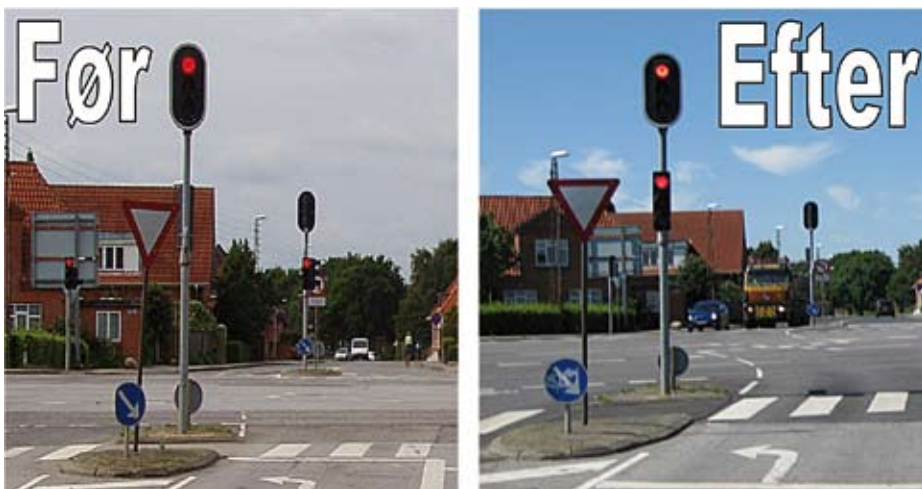
Figur 1. Fotos af ombygget kryds hhv. før (venstre) og efter (højre) ombygning.
