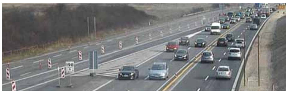
Figur 2. Udvidelse af Østjyske Motorvej, M60. Foto: Trafitec.
