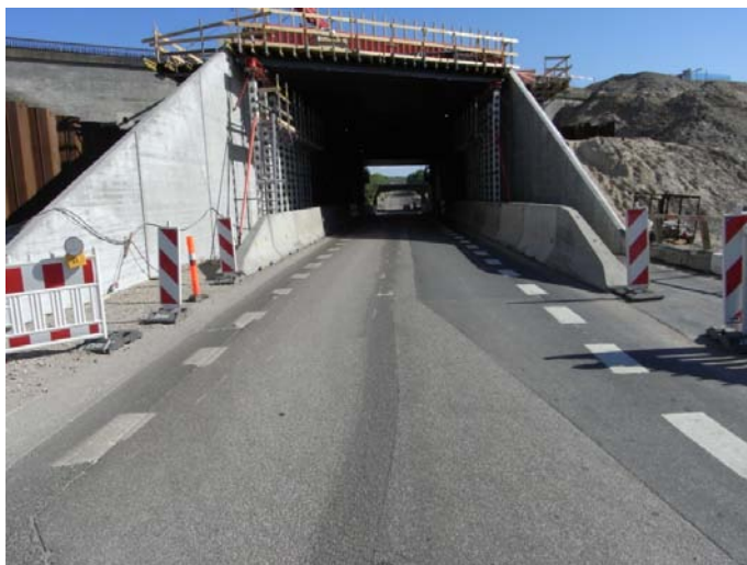
Figur 1: 2-1 strækningen på Marbjergvej.
