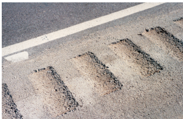
Figur 3: Nedfræsede rumlestriber (ref. 8) skæres ud i den eksisterende vejbelægning ved brug af en roterende tromle forsynet med skærehoved.
