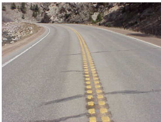
Figur 6: Fortløbende nedfræsede rumlestriber langs midtlinien.
