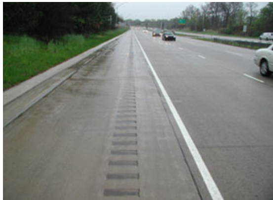
Figur 5: Fortløbende nedfræsede rumlestriber langs kantlinie (ref. 8)
