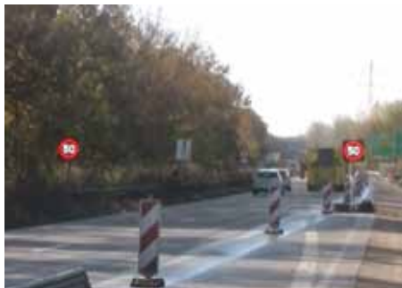
Figur 5. Motorring 4. De elektroniske tavler tændes med visning 50 km/t, hvorefter chaufføren i arbejdskøretøjet får besked om, at han må køre ud fra arbejdszonen i midterrabatten. Foto: Trafitec.
