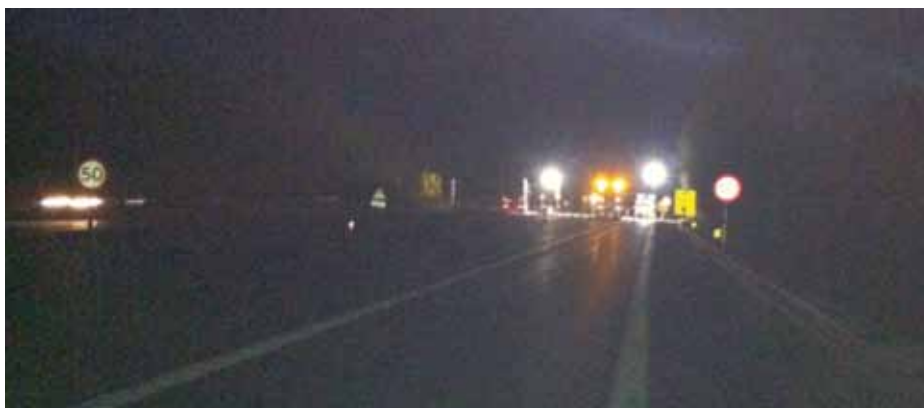
Figur 4. Testopstilling med 2 PowerMoons på Vestmotorvejen, hvor hastigheden nedskiltes fra 80 til 50 m/t. Foto: Trafitec.
