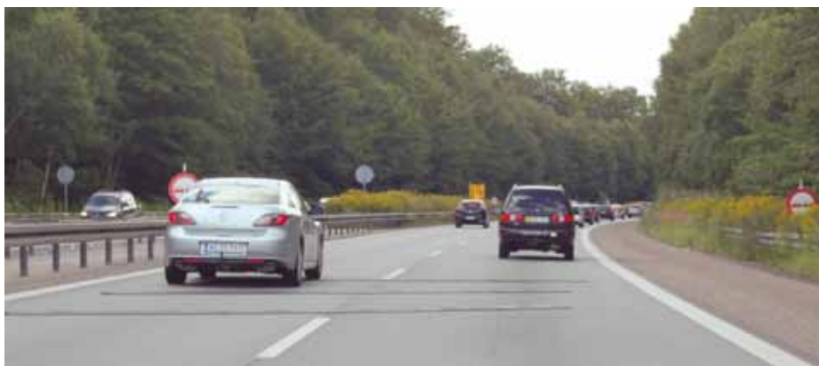
Figur 2. Hillerødmotorvejen. Rumlestriberne har forskubbet sig og ligger i ca. 45 grader på tværs af køreretningen. De er skubbet mere i det højre kørespor end i det venstre. Foto: Trafitec.
