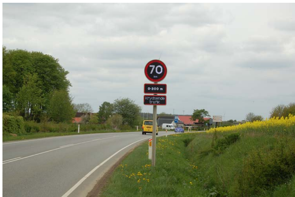
Figur 3.8: Aktiveret VMS tavle med undertavle, der informerer bilisten om, at hastighedsgrænsen reduceres til 70 km/t fordi der er krydsende trafik
