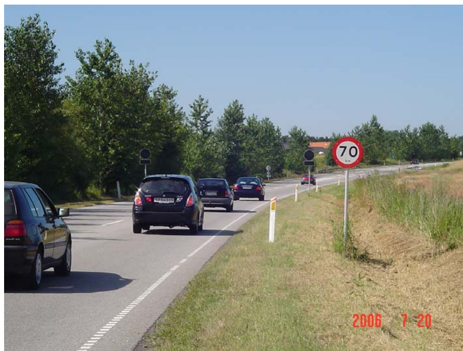
Figur 3.3: Hundestedvej. VMS - tavlen er slukket, når der ikke er trafik fra sidevejen
