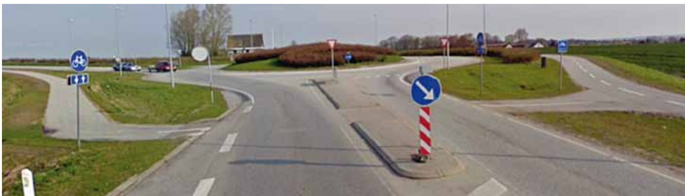
Figur 5. 1-sporet rundkørsel med samlet diameter på 31 m, høj midterø, cirkulations-, tilfarts- og frafartsspor på hhv. 6,7 m, 3,7 m og 4,3 m, trekantsheller og separat sti – ikke så ringe endda.
