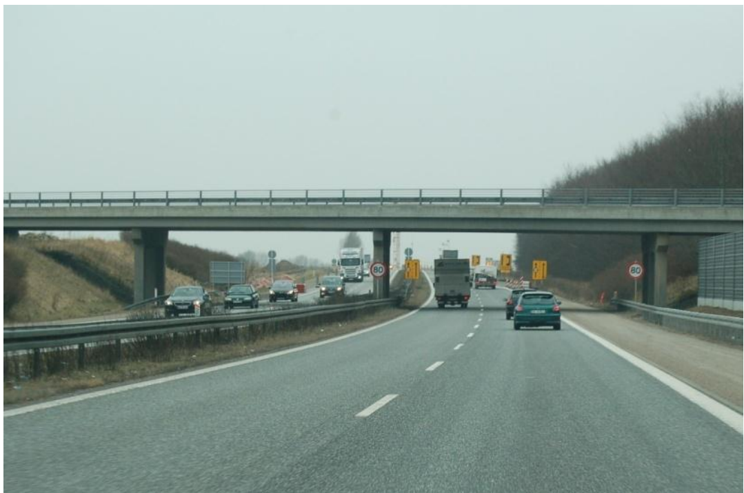
Foto 1. Ca. 200 m før rumlestriberne.
