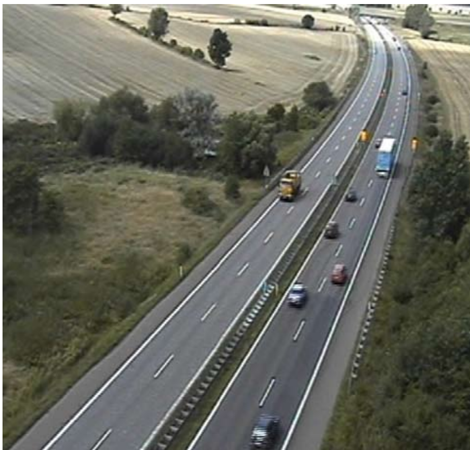
Figur 2. Forsøgsstrækningen på motorvej M40 på Fyn i vestlig retning.
