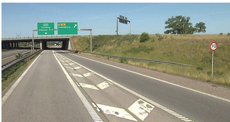
Figur 2.4: Grøn portaltavle i motorvejskrydset mellem den fynske motorvej og Svendborgmotorvejen. Versalhøjden er 340 mm.
