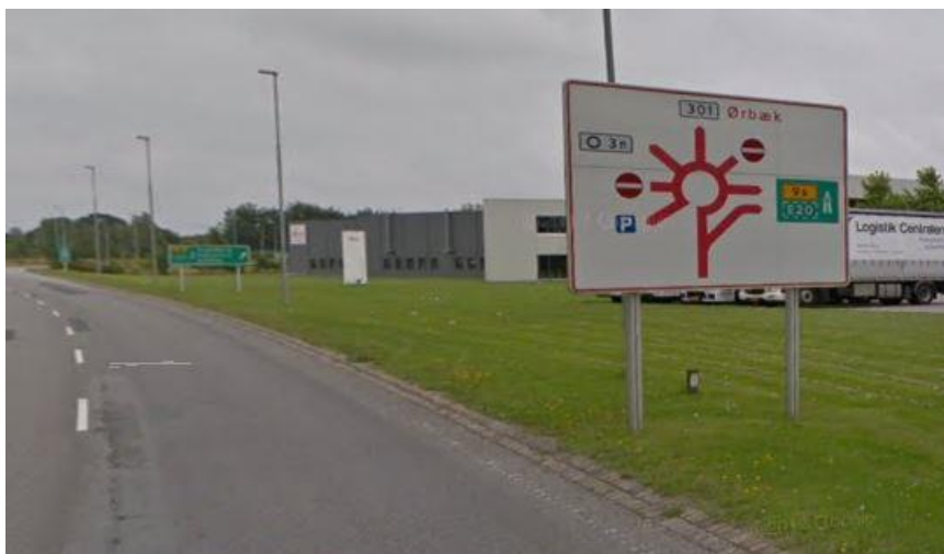
Figur 2.1: Rød/hvid diagramtavle på Ørbækvej i Odense. Versalhøjden på diagramtavlen er 143 mm og diagrambredden på rundkørselsdiagrammet er 125 mm. I baggrunden ses den grønne vejvisningstavle F34, hvor versalhøjden er 170mm.
