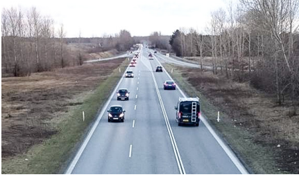
Figur 2. 2+1 vej med dobbeltoptrukket spærrelinje mellem køreretninger.
