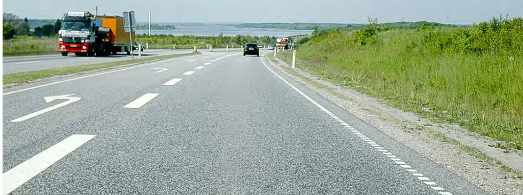
Figur 2. Profilerede striber i vejkanterne i Danmark.
