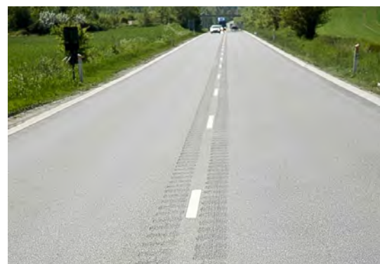
Figur 1. I Danmark er rumleriller i vejmidten hidtil etableret som to striber, én på hver side af midtlinjen som på billedet. I USA synes det mest almindelige at være én fræset stribe placeret under midtlinjen.
