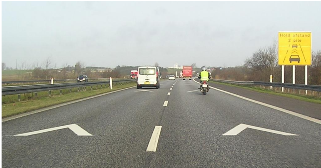
Foto fra motorvejsstrækning med afstandsmærker.
